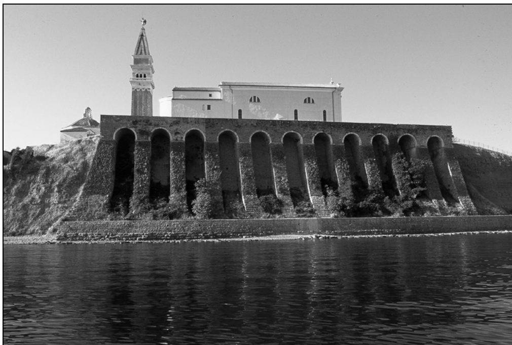
Sl. 2: Piran, kompleks cerkve sv. Jurija in utrditev brežine (Arhiv Zavoda za varstvo kulturne dediščine Slovenije, Območna enota Piran).
